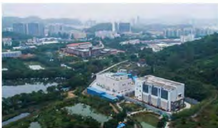
南网珠海“互联网+”智慧能源 示范工程项目
