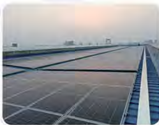
大型屋顶光伏电站
